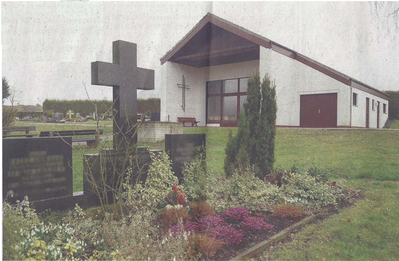
Die Friedhofskapelle in Barterode soll neue Fenster bekommen.
